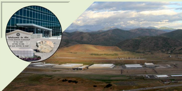
Fig. 1.4. Utah Data Center
